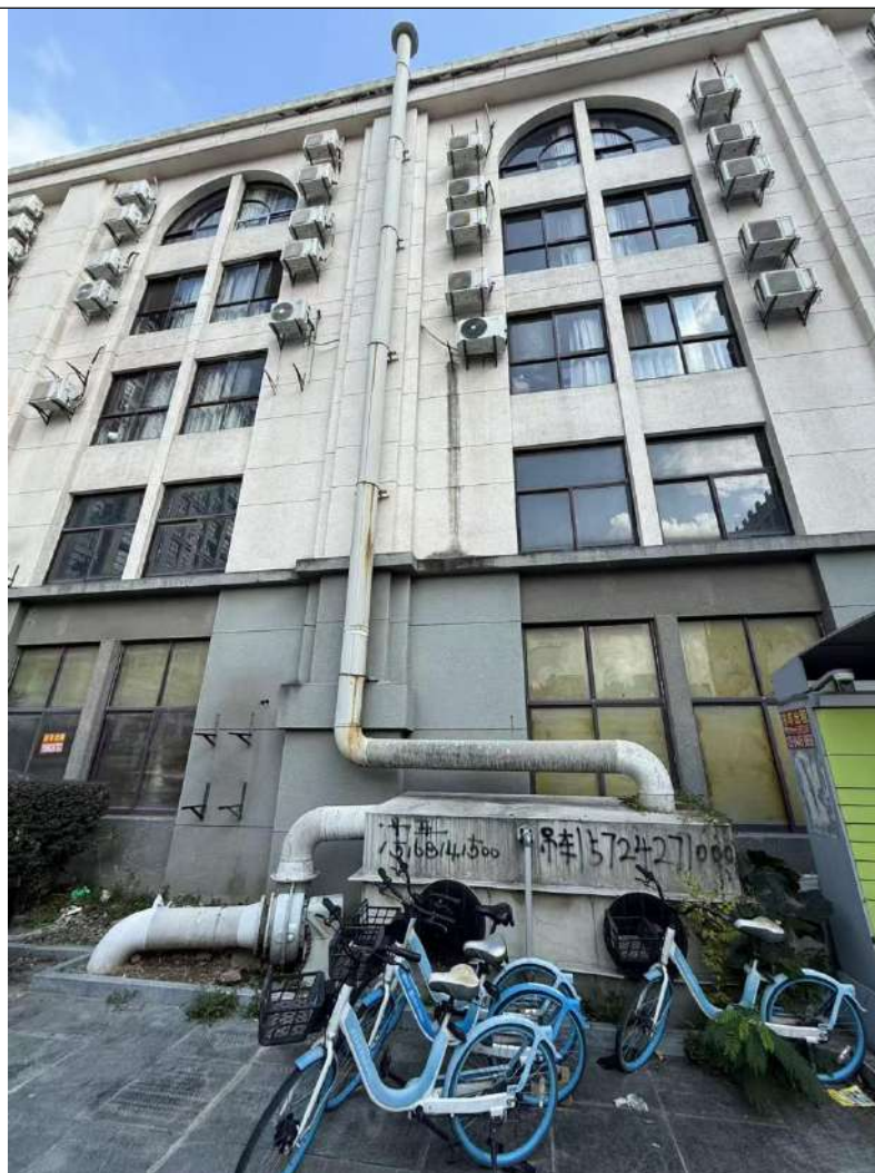
废气处理设施
